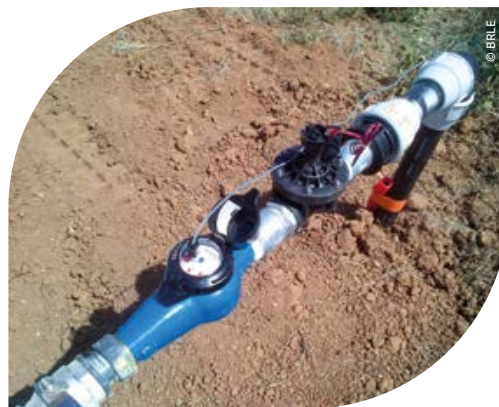
Compteur et électrovanne télégérés
